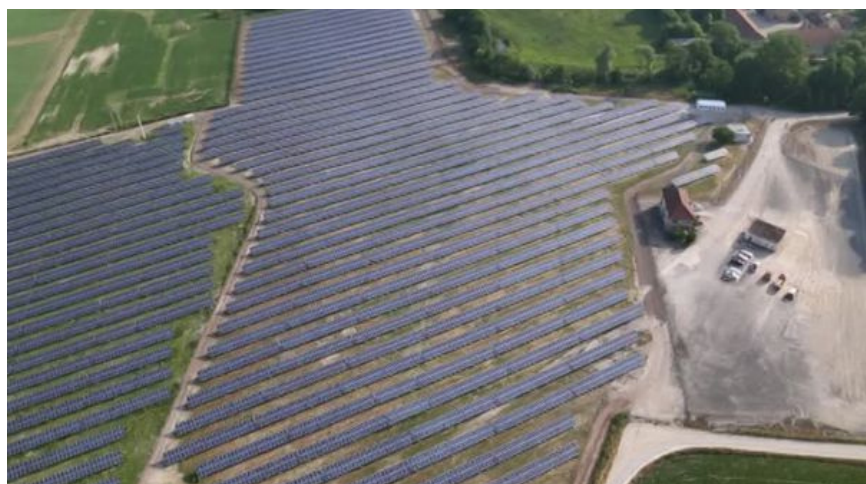
Centrale solaire de Bétheny (51)
