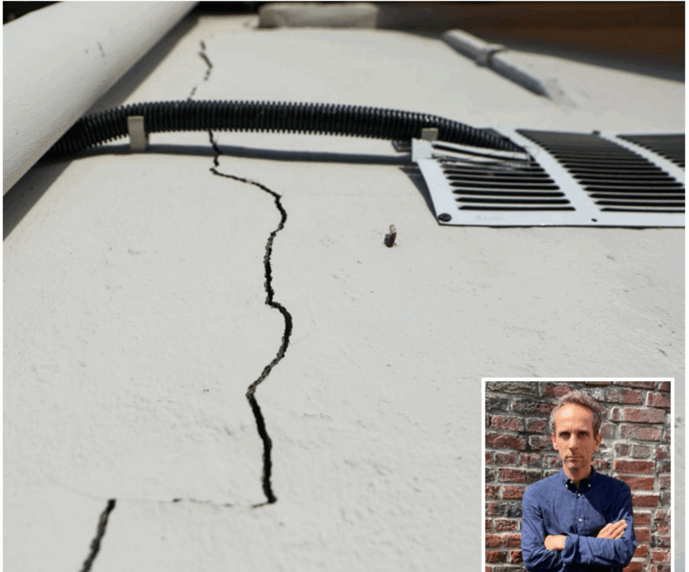
Avec la sécheresse, le mouvement de retrait-gonflement des sols argileux crée des fissures. Selon le chercheur Marc Dumont, la France a les techniques suffisantes pour adapter les habitats. PHOTOS THIERRY THOREL ET « LA VOIX »
