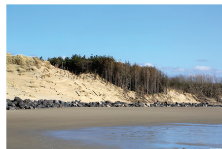
Dune avec enrochement à son pied (La Baie d'Authie - 62)
